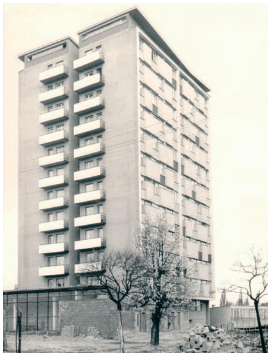
Pierwszy 11-kondygnacyjny budynek w Częstochowie, zbudowany przez CSM „Nasza Praca” przy ul. Zawadzkiego 2. Fot. Archiwum CSM „Nasza Praca”
