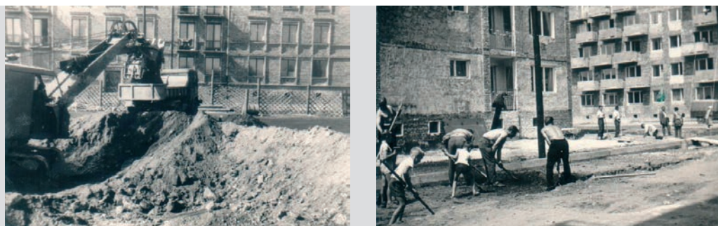
Prace budowlane ekip Naszej Pracy na Starym Mieście. Fot. Archiwum CSM „Nasza Praca”
