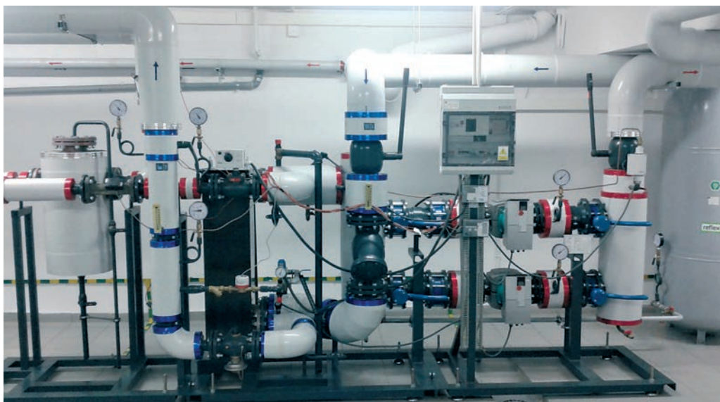
Węzeł ciepły. Zakład Obsługi Technicznej. Fot. P. Klimek
