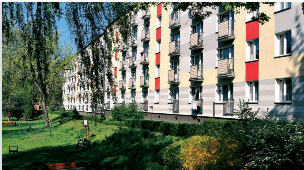
Termomodernizacja zasobów CSM „Nasza Praca”. Fot. P. Klimek
