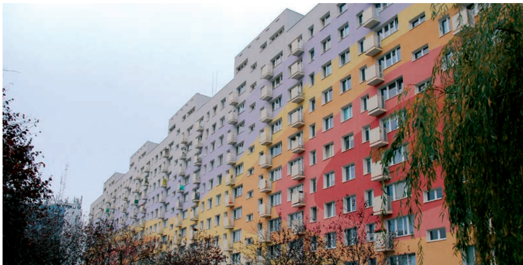
Mrówkowiec, widok od al. Armii Krajowej. Fot. Archiwum CSM „Nasza Praca”
